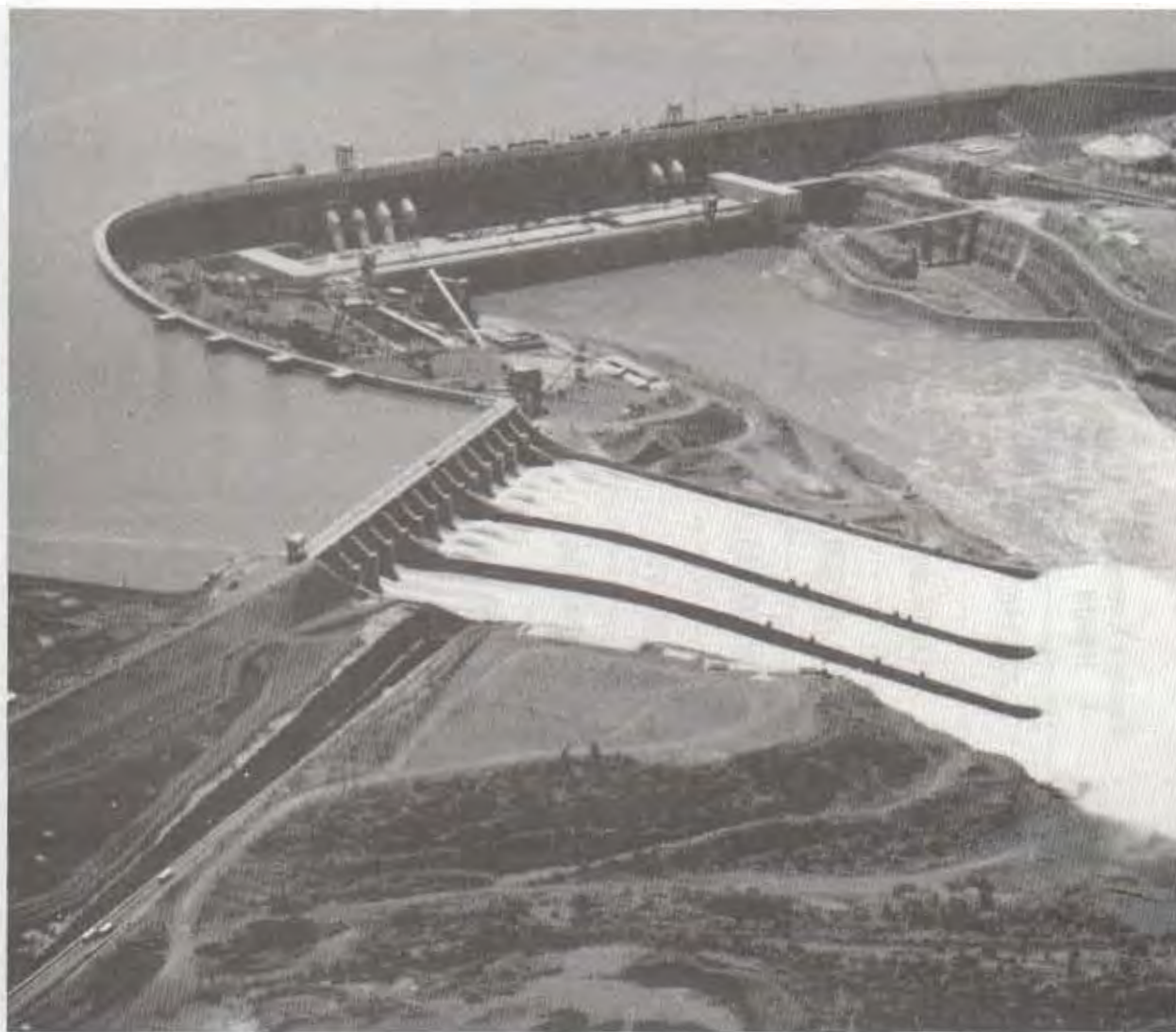
Vista de la central hidroeléctrica de Itaipu, al iniciarse el año 1986, teniendo cuatro unidades generadoras de 50 Hz en servicio y seis unidades en montaje — dos de 60 Hz y cuatro de 50 Hz — en diferentes etapas.
