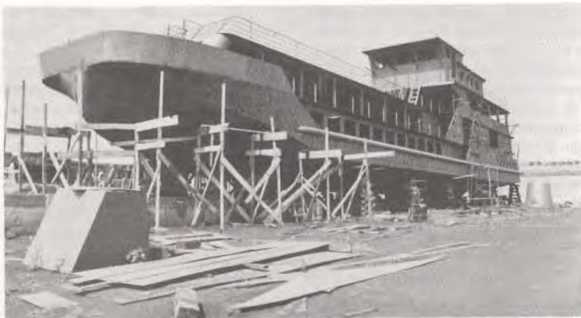
La primera de una serie de embarcaciones de turismo en construcción en el astillero privado, en implantación en la margen izquierda del embalse de Itaipú, situado a 15 km al norte de la ciudad de Foz de Yguazú. Se trata de una embarcación construida con chapas de acero, con capacidad para 300 personas, a ser entregada a la navegación del lago de Itaipú, a mediados de 1986.
